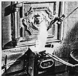
Seine automatische Feuerhexe entzündet den Ofen. Werns holt sie, glüht ein Widerstandsdrab an und setzt die vorbereitete Feuerung in Brand. Alle Geräte hat er aus alten Klammern selbst gebaut.
