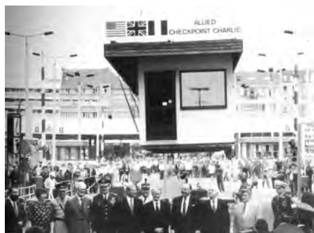
Abb. 5: Feierliche Demontage des Kontrollhäuschens der Westalliierten im Juni 1990
